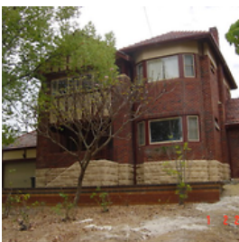
Victoria Park (Riverbank) Annexe
